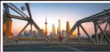
สะพานไวปี้ดู่
