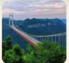
สะพานอ้ายจ้าย
